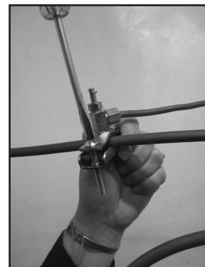
**14.** Conéctese a la tubería de abastecimiento de agua usando la válvula incluida de tipo sillín. Siga las instrucciones abajo:
