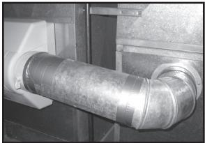
rond de 6 po (15,24 cm) de long pour la connexion. Visser le conduit de 6 po (15,24 cm) sur la bague de déversement.
