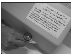
3. Quite la tapa del humidecedor del marco de montaje girando el tornillo de pulgar en la parte inferior en sentido contrario al de las manecillas del reloj (→).
