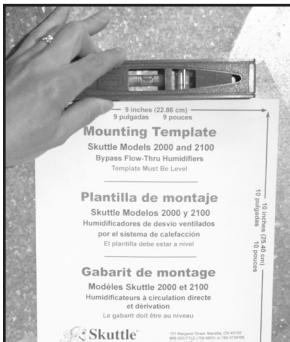
1. Busque la plantilla para el montaje de los modelos 2000 o 2001 en la caja del humidificador. Usando cinta adhesiva, péguelo longitudinalmente en el plenum del sistema de calefacción, **asegúrese de que esté a nivel.**
