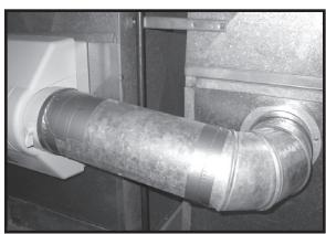
**11.** Instale en el otro plenum el collar de base de 6 pulgadas (15.24 cm). Luego conecte un codo de 90° y mida la distancia necesaria para hacer la conexión con un conducto tubular de 6 pulgadas (15.24 cm). Conecte el conducto de 6 pulgadas (15.24 cm) al collar de descarga con tornillos.
