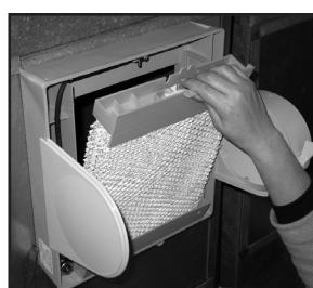
9. Coloque la bandeja de escurrimiento encima del filtro de evaporación. Vuelva a instalar el filtro de evaporación y la bandeja de escurrimiento.
