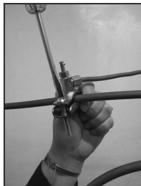
**14.** Conéctese a la tubería de abastecimiento de agua usando la válvula incluida de tipo sillín. Siga las instrucciones abajo:
