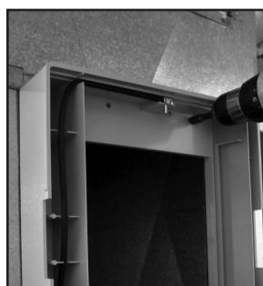
7. Coloque el marco de montaje en la abertura del plenum para que el marco se enganche en la parte inferior de la abertura. Instale el marco en el plenum con tornillos.
