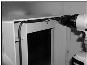
6. Coloque el marco de montaje en la abertura del "plenum" para que el marco se enganche en la parte inferior de la abertura. Monte el marco en el "plenum" con tornillos.
