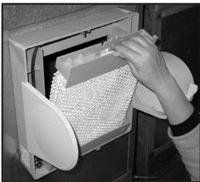
8. Placer le plateau d'égouttage pardessus le tampon. Réinstaller le tampon évaporateur et le plateau d'égouttage.
