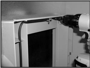
6. Placer le cadre de montage dans l'ouverture du plénum pour qu'il s'accroche en recouvrant le bas de l'ouverture. Visser le cadre de montage dans le plénum.
