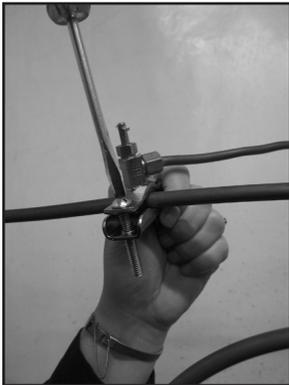
**12.** Raccorder à une conduite d'eau en utilisant le robinet-valve à étrier inclus. Suivre le mode d'emploi fourni sur l'emballage du robinet-valve à étrier.
