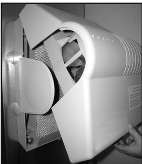
9. Réinstaller le couvercle d'assemblage en l'accrochant sur le dessus du cadre de montage. Sécuriser le tout en tournant la vis à serrage à main qui se trouve dans le bas dans le sens des aiguilles d'une montre (↻).
